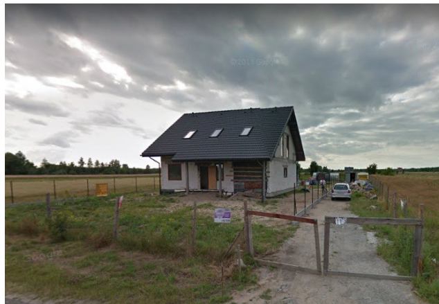
Fot.4. Zabudowa mieszkaniowa w trakcie budowy przy ul. Wierzbowej
